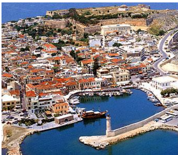
Εικόνα 3. Αεροφωτογραφία της Παλιάς Πόλης με την Φορτέτζα και το βενετσιάνικο λιμάνι.
