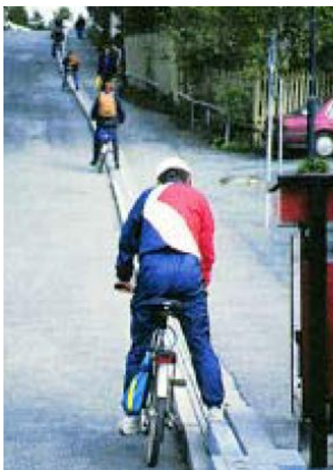
Μηχανισμός κυλιόμενου ιμάντα για ανύψωση ποδηλάτου στην ανηφόρα.
