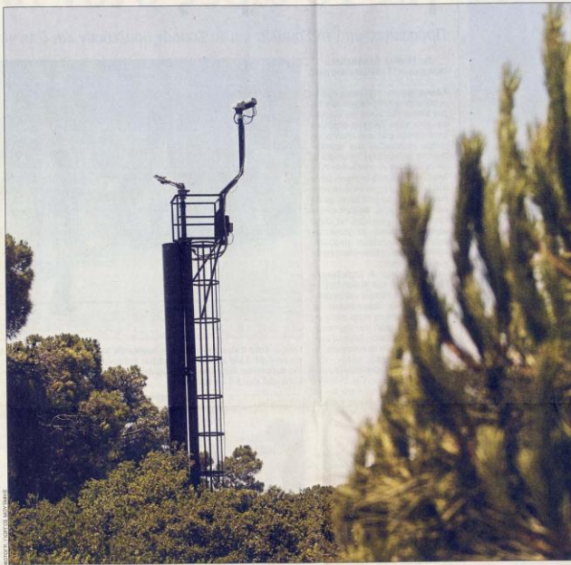
Οι 25 μεταλλικοί πύργοι, πάνω στους οποίους υπάρχουν κάμερες και κανόνια εκτόξευσης νερού, με δυνατότητα περιστροφής, την τεθούν εκτός μάχης λειτουργώντας από το κέντρο ελέγχου, που βρίσκεται εντός του Κοιμητοδρόμιου.
