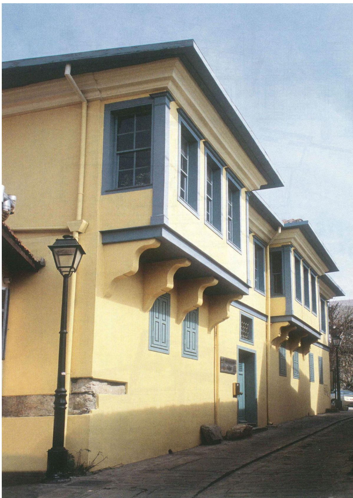
Εικόνα 6. Νοτιοδυτική άποψη μετά την αποκατάσταση
