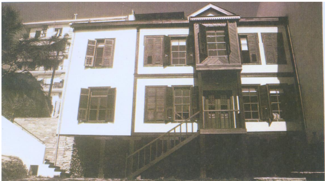
Εικόνα 2. Άποψη της νότιας όψης του κτιρίου μετά την ολοκλήρωση των εργασιών αποκατάστασης.
