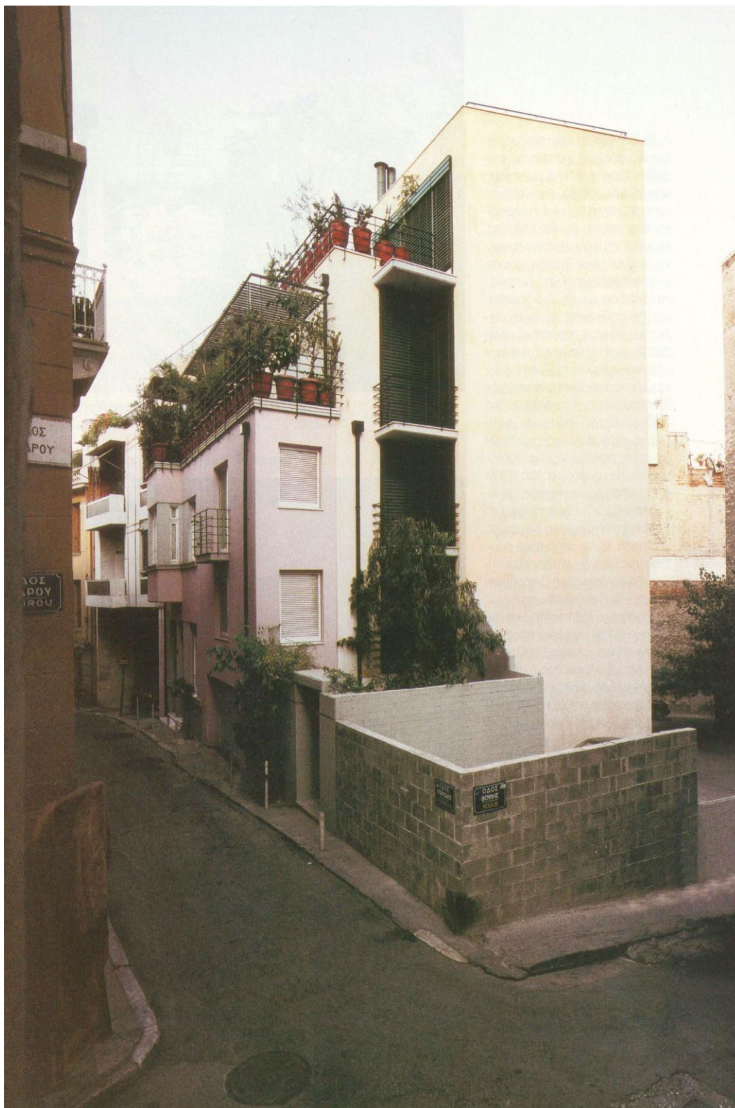
Εικόνα 9. Νοτιοδυτική άποψη μετά την αποκατάσταση και την επέκταση
