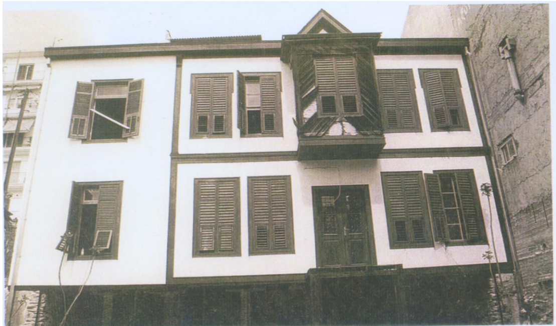
Εικόνα 1. Έναρξη εργασιών ολοκλήρωσης εργασιών αποκατάστασης
