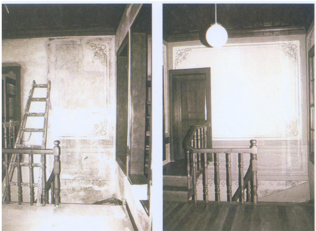
Εικόνα 3. Ο χώρος του εσωτερικού κλιμακοστασίου πριν και μετά τις εργασίες αποκατάστασης.
